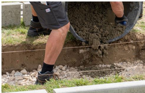
Prüfe danach mit der Wasserwaage, ob die Richtschnur selbst in der Waage hängt und justiere gegebenenfalls noch einmal nach. Schachte nun auf eine Tiefe von 30 cm von der Richtschnur aus gemessen aus.
