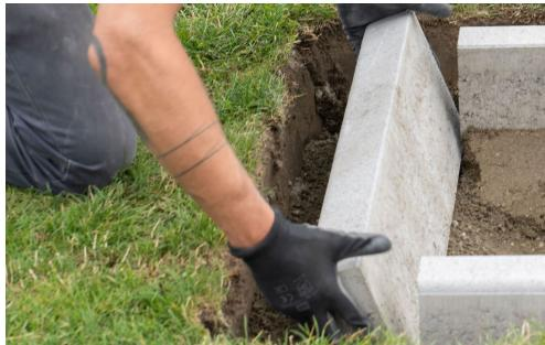
Das Endstück schneidest du passend zu, indem du mit der Richtlatte den Abschnitt ausmisst, den Abstand auf dem Randstein markierst und diesen mit dem Winkelschleifer zuschneidest.
