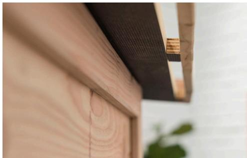
Wenn du jetzt noch durch das obere Ende des Rahmens und durch die von innen am Dach angebrachte Leiste bohrst, kannst du die Scharnierbolzen durch die Bohrlöcher schieben, um das Dach so gegen Wind und Wetter zu schützen. Setze nun die beiden Module für den Innenraum, also für die Nester und die Hühnerstangen ein und fixiere sie mit Holzleisten, die du rechts und links davon anbringst. Jetzt noch die Kotschublade einschieben – fertig? Ja! Du hast es geschafft und dein Hühnerstall steht.
