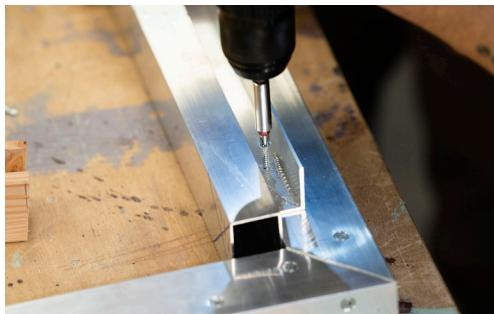
Oben auf den Rahmen werden mithilfe von selbstschneidenden Schrauben L-Profile gesetzt, an denen das Gewächshaus später mit dem Rahmen verschraubt wird. Bohre hier nicht zu schnell und behalte eine ruhige Hand, damit die Schrauben nicht wegrutschen. Das Problem ist jetzt noch, dass Wasser in die Nut der Seitenelemente laufen kann und sich dort sammelt. Um das zu verhindern, bohrst du ein paar Drainagelöcher schräg in die unteren Nuthölzer.
