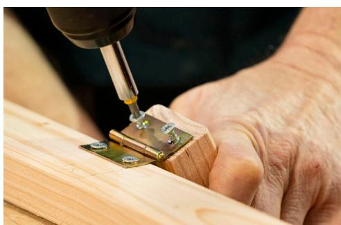
Für den Griff benötigst du ebenfalls ein Kantholz. Schneide es lang genug zu, damit du gut darankommst und das Fenster weit genug öffnet. Schraube den Griff mit einem Scharnier an den Auflageträger. An der Stirnseite des Griffs nimmst du am besten eine etwas längere Schraube, damit die Konstruktion stabil ist.
