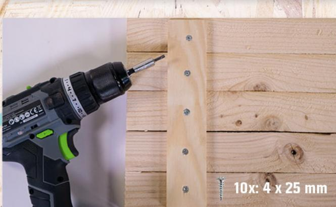
Jetzt legt ihr die schmaleren Holzleisten auf die fünf dickeren Dachlatten. Eine ca. 5 cm vom rechten und eine ca. 5 cm vom linken Rand entfernt. Dann nehmt ihr den Akkuschrauber und schraubt alle Teile mit je fünf Schrauben (4 x 25 mm) pro Holzleiste zusammen.
